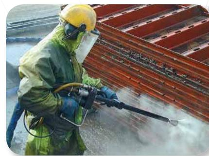
При использовании пескоструйной насадки аппарат используется, как гидроабразивная установка, не требуется дополнительно ни компрессор, ни бункер для песка, преимущества водопескоструйной очистки:
